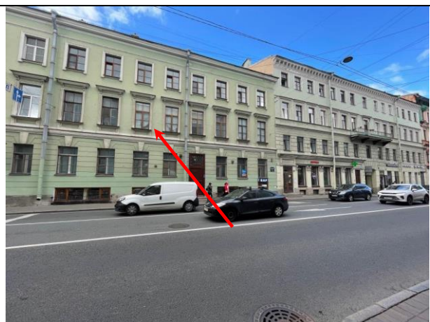
Фото 14. Вид здания расположения Объекта оценки
