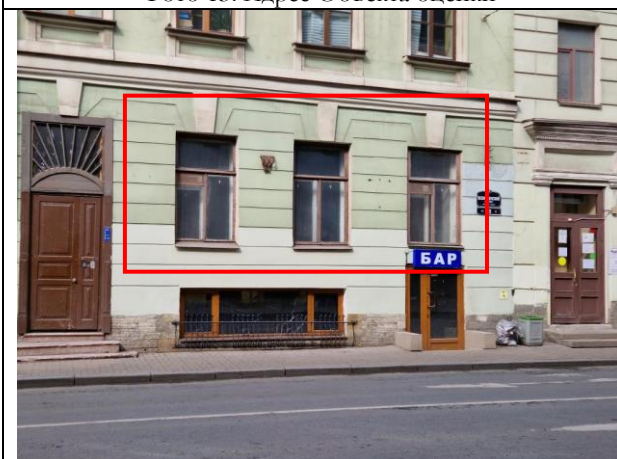
Фото 15. Оконная Объекта оценки
