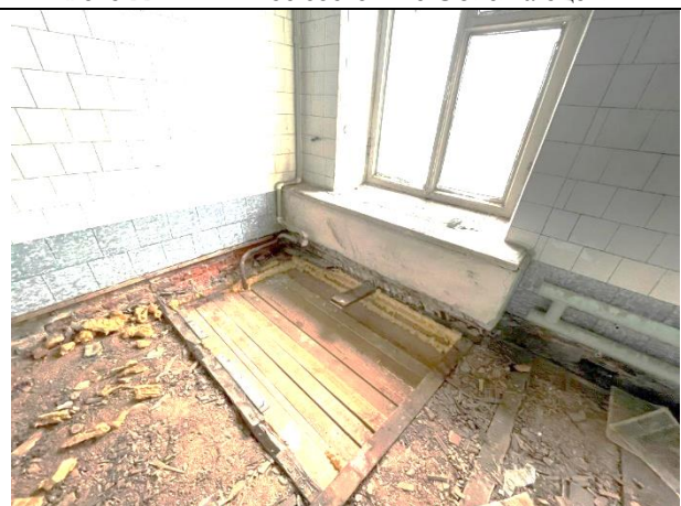
Фото 24. Типичное состояние Объекта оценки
